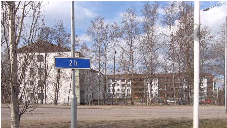
Kuva: Keskuskadun ja Muikkuojankadun risteyksessä ovat AS Oy Muikkuojan lamellit 1970-luvulta, saneerattu. Talojen kattomalli on muutettu tasakatosta harjakatoksi 2000-luvulla.
