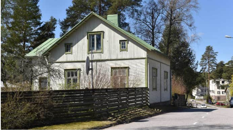
Kuva: Koskensaarentie 14 asettuu vanhan rakennustavan mukaan tontin kadun puoleiseen reunaan. Rakennuksella on keskeinen sijainti koulua vastapäätä. Rakennus on yksi alueen harvoista 1900-luvun alun asuinrakennuksista, jossa on säilynyt alkuperäiset julkisivujen mittasuhteet ja tasapainoinen ilme.
