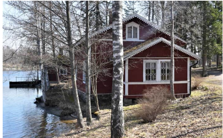
Kuva: Lilla byggnad – nimisenä tunnettu Forskullan entinen vierasmaja.
