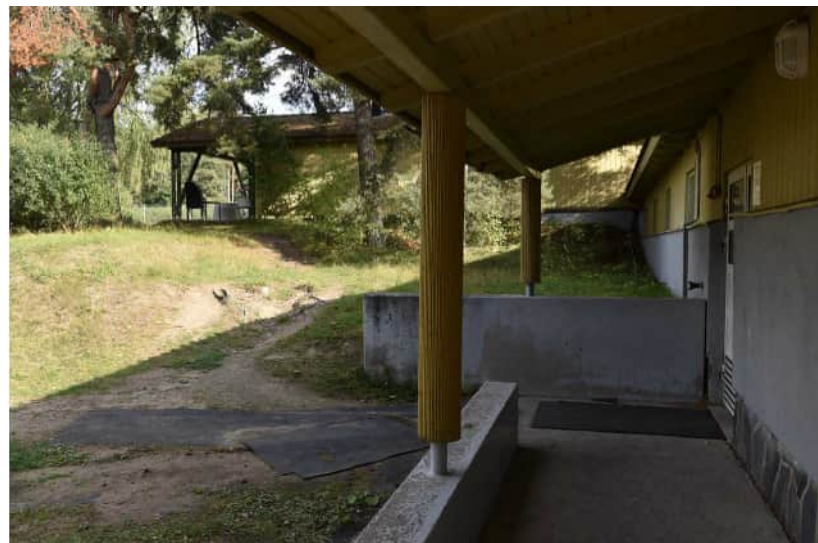
Kuva: Pukusuojaasiiven pohjoisjulkisivun ovelle johtavaa katosta ei ole vuoden 1950 piirustuksissa. Alun perin ovi sijaitsi päädyssä (jossa nyt ikkuna). Ilmakuvista päätellen katos on tehty aikaisintaan 1960-luvulla, mutta yksityiskohdiltaan samanlaisena (pylväät ja katonkannattajien muotokieli).
