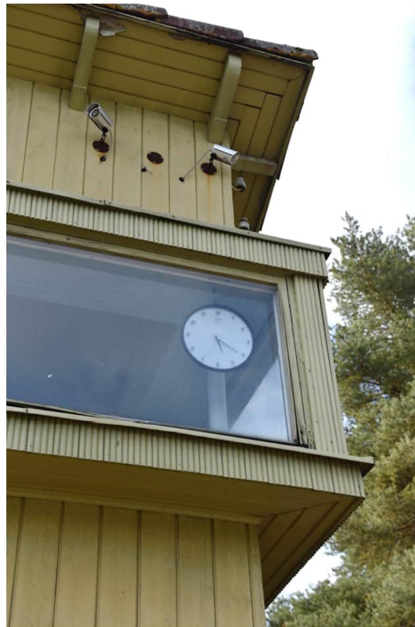
Kuva: Pukusuojarakennuksen kuuluttamon kulmaikkuna.
