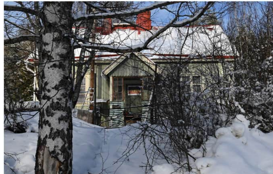
Kuva: Julkisivu radan suuntaan.
