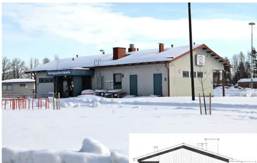
Kuva: Julkisivu laitureille päin.
