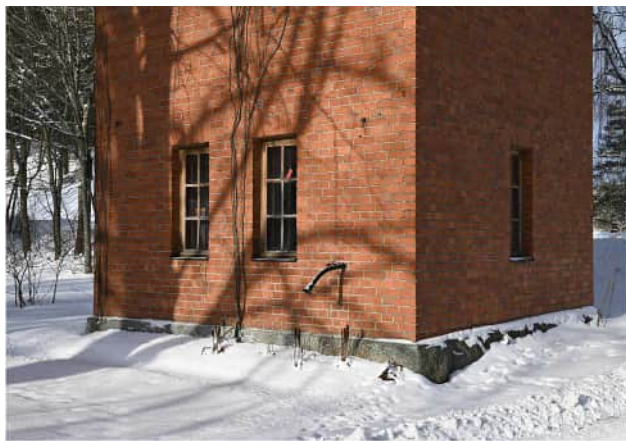
Kuva: Lohkokivijalka. Kapeat ikkunat.
