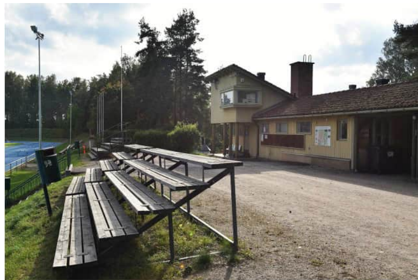
Kuva: Urheilukentän pukusuojarakennus ja yleisurheilukentän katsomo.
