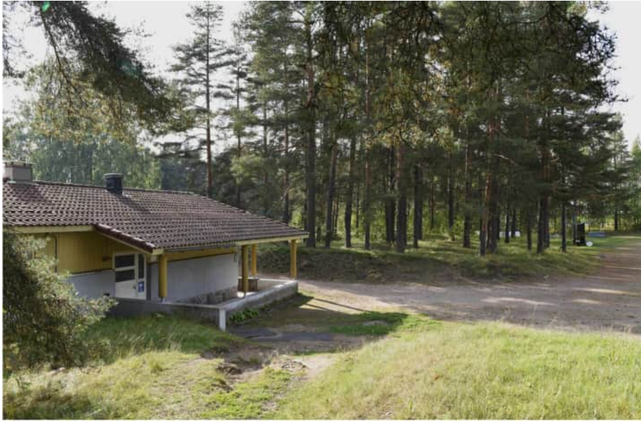
Kuva: Pohjoissivun katoksellinen sisäänkäynti. Metsäpohjoinen viheralue.
