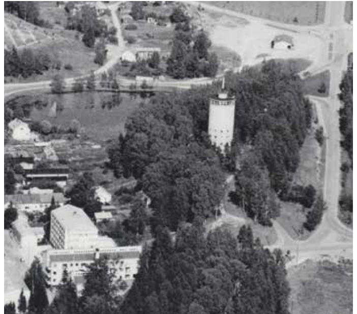
Heinolan vesitorni Harjupuistossa 1963 kauppakadun suunnalta. /HKMA
